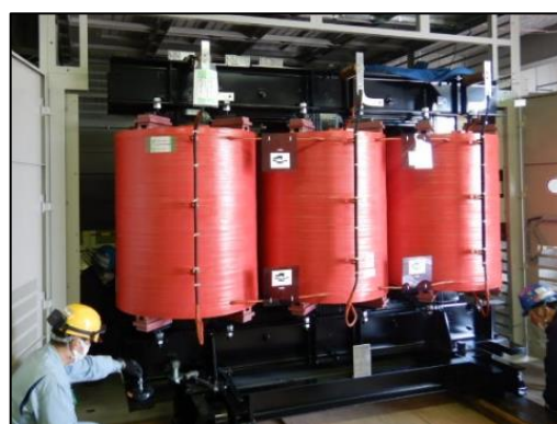
万博公園変電所更新工事
