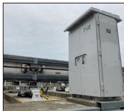
分岐器制御盤更新工事
